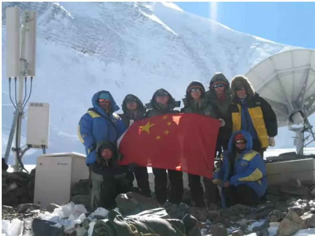
（华为在珠峰架设的基站）
